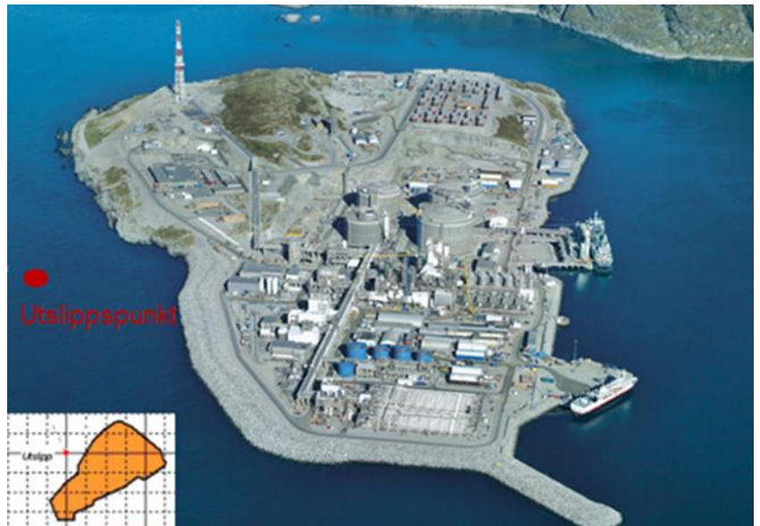
Figur 3.2. Hammerfest LNG og utslippspunkt for produsert vann. Utslippspunkt fra vannrenseanlegg 130 m fra land på 30 m dyp
