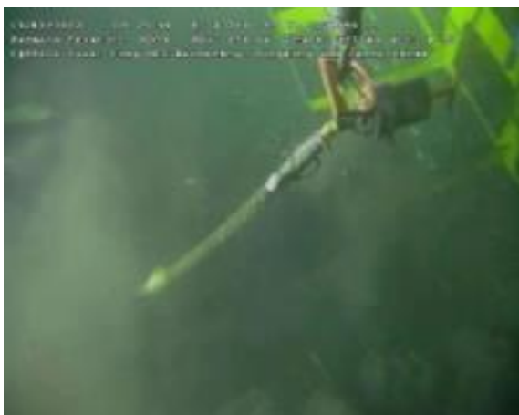
Figur 6-108 HFL UL-18-7035 plukkes opp fra pipemat på sjøbunnen ved UTA-1
