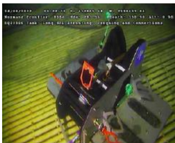
Figur 6-83 HFL UL-18-6003 plassert i momentramme ved UTA-2
