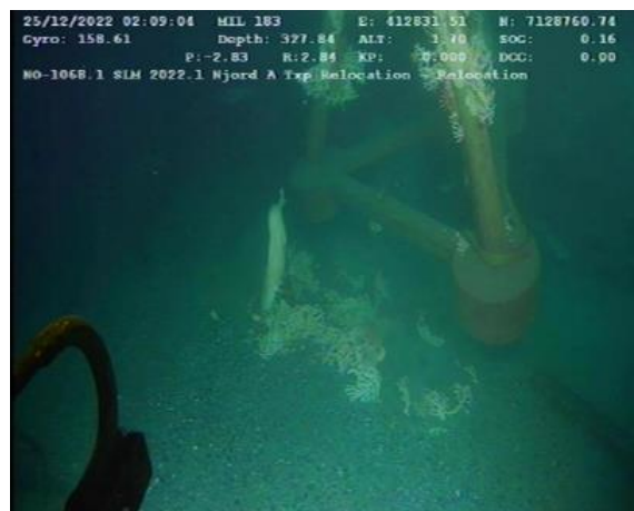
Figur 6-160 Støtten forsøkes løftet av sjøbunnen ved hjelp av kran
