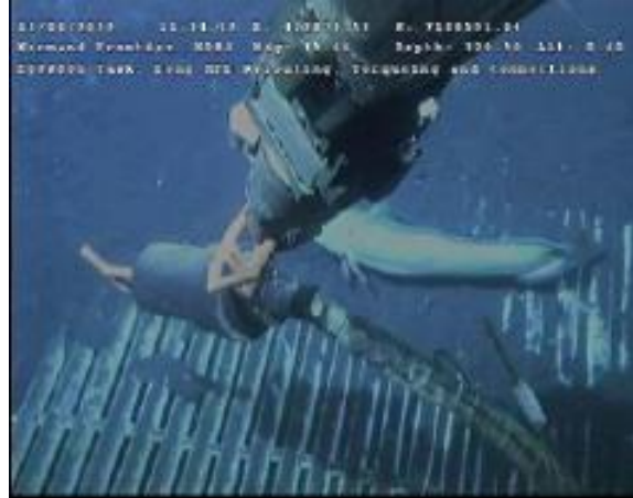
Figur 6-105 HFL UL-18-7034 plukkes opp fra pipemat på sjøbunnen ved UTA-1
