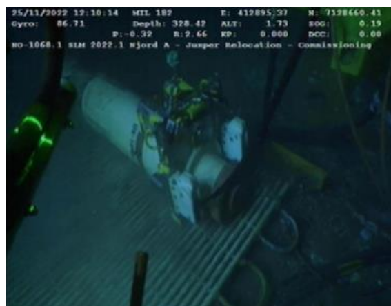
Figur 6-125 Jumper 14B, 2. ende, på pipe mat
