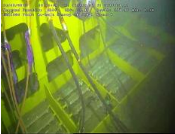
Figur 6-97 Hydrauliske kabler ferdig utbedret og koblet til UTA-2
