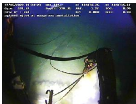
Figur 6-57 Relokering av EFL til våtlagringsområde
