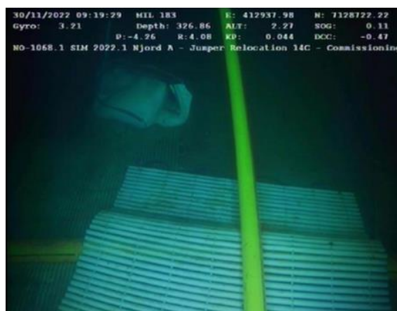
Figur 6-152 Jumper 14C, lagt over Riser S17 med en pipemat mellom
