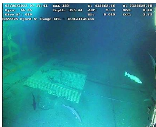
Figur 6-78 EFL landes på pipemat ved UTA-2
