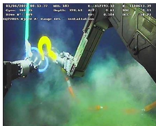
Figur 6-66 Tilkobling av rigging til EFL
