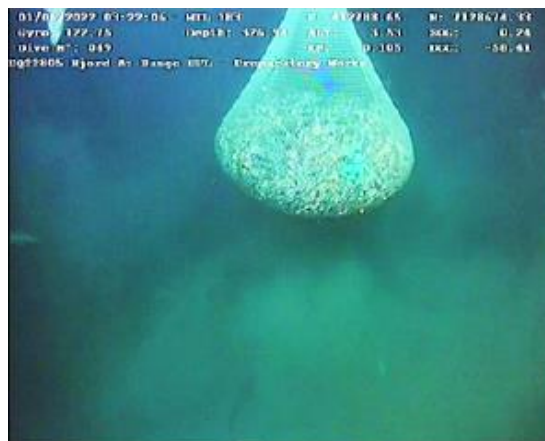
Figur 6-64 Installasjon av Filter Unit
