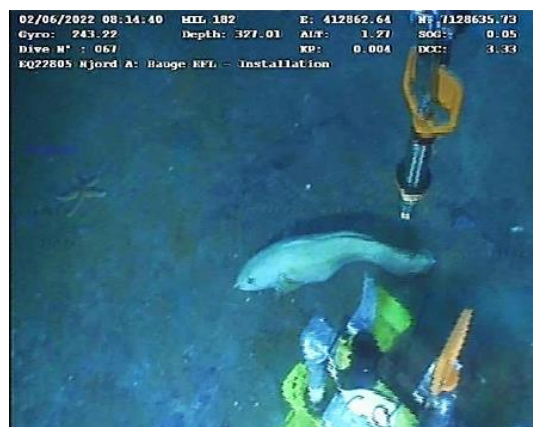
Figur 6-80 ROV fjerner stab fra parkeringsstativ
