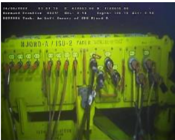
Figur 6-95 Hydrauliske kabler ferdig utbedret og koblet til UTA-2
