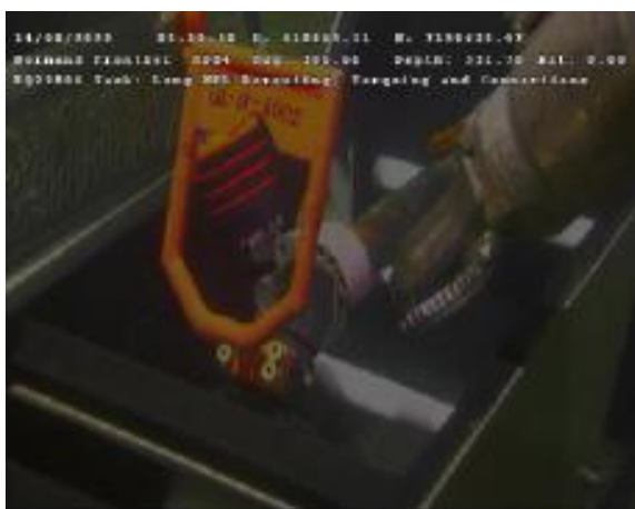
Figur 6-89 Anti Rotasjonsklemme installeres på HFL UL-18-6002
