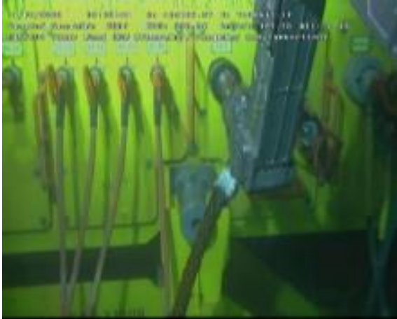
Figur 6-91 LP3 Plast-stab fjernes fra UTA-2
