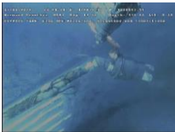
Figur 6-102 HFL UL-18-7033 plukkes opp fra pipemat på sjøbunnen ved UTA-1
