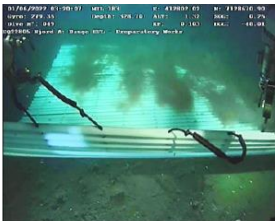
Figur 6-63 Installasjon av Pipe Mat
