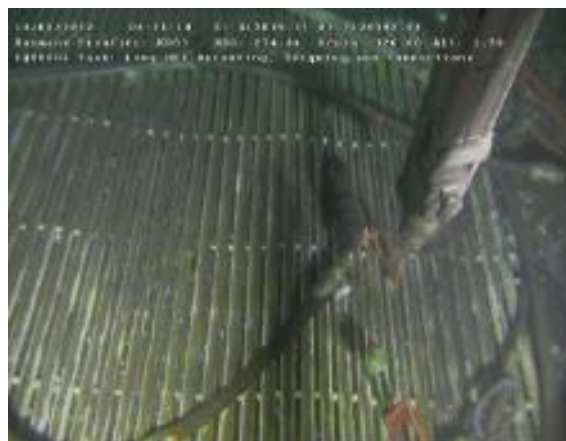
Figur 6-99 HFL UL-18-7032 plukkes opp fra pipemat på sjøbunnen ved UTA-1
