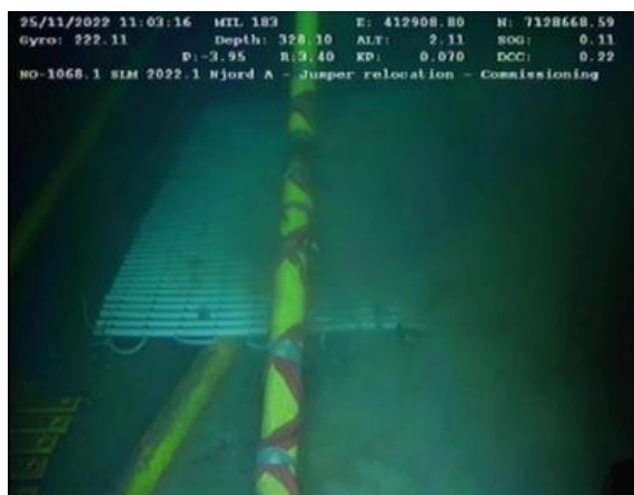
Figur 6-124 Jumper 14B lagt over pipe mat
