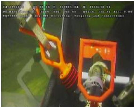
Figur 6-85 Antirotasjonsklemme installeres på HFL UL-18-6003
