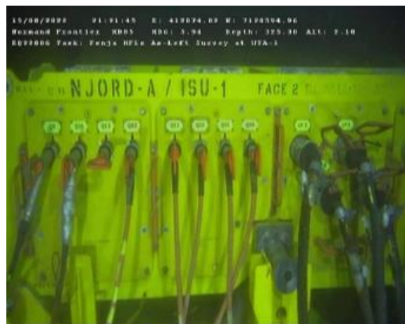
Figur 6-115 Hydrauliske kabler ferdig utbedret og koblet til UTA-1
