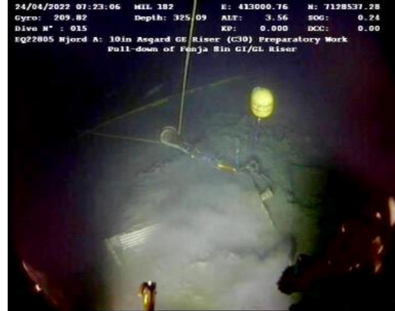
Figur 6-50 Nedtrekk av Fenja GI/GL
