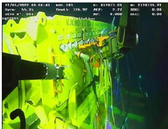
Figur 6-55 Frakobling av EFL fra ISU-2 EC9
