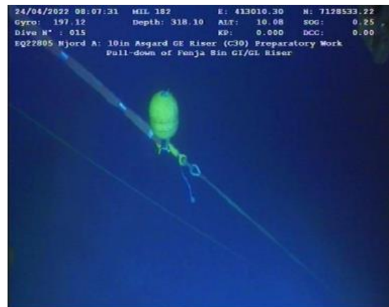
Figur 6-52 Nedtrekk av Fenja GI/GL
