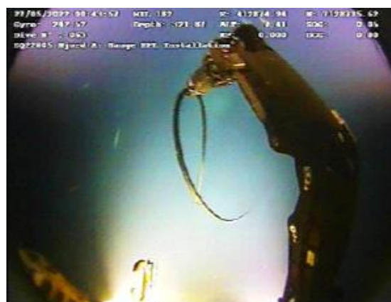
Figur 6-58 Relokering av EFL til våtlagringsområde
