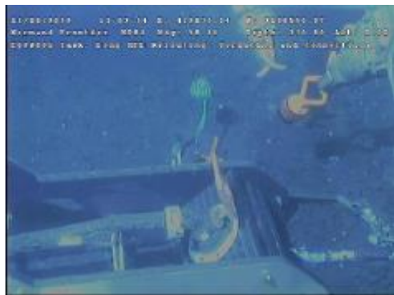
Figur 6-107 Antirotasjonsklemme installert på HFL UL-18-7034
