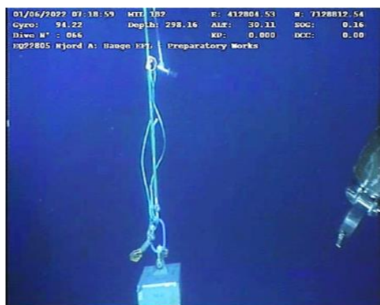
Figur 6-65 Ny Bauge EFL koblet til kran og senkes
