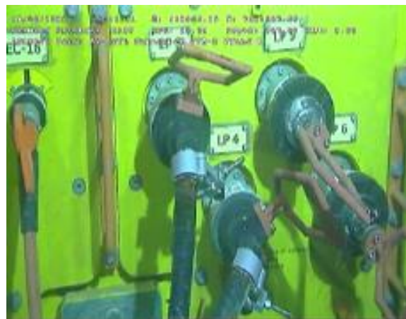
Figur 6-96 Hydrauliske kabler ferdig utbedret og koblet til UTA-2
