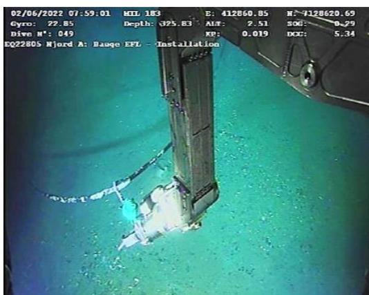
Figur 6-79 ROV flytter på EFL og ruter mot parkeringsstativ
