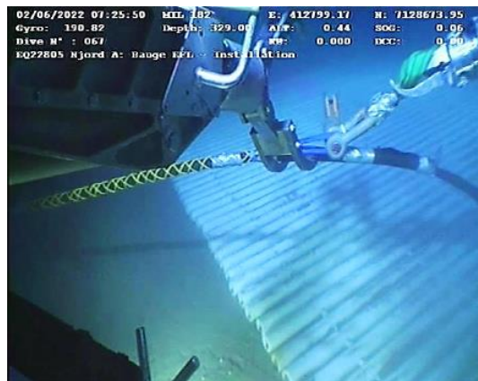
Figur 6-76 ROV løfter opp 1. ende av EFL
