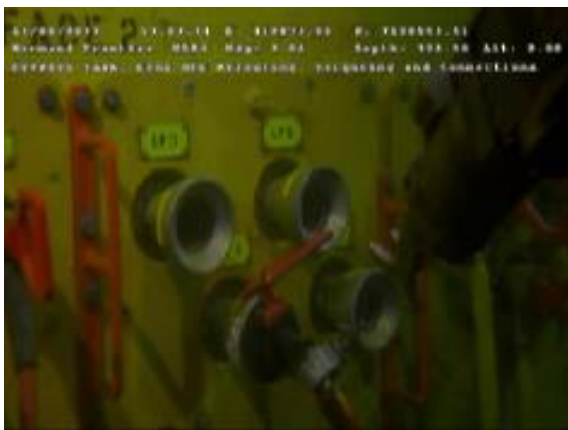
Figur 6-112 HFL UL-18-7033 koblet til LP4
