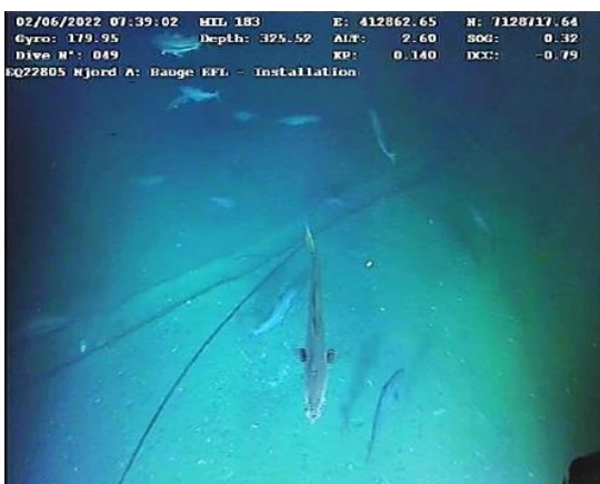
Figur 6-77 ROV starter å rute EFL'en mot UTA-2
