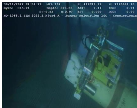
Figur 6-149 Jumper 14C, 2. ende, tilkoblet FLA, løftes fra sjøbunn
