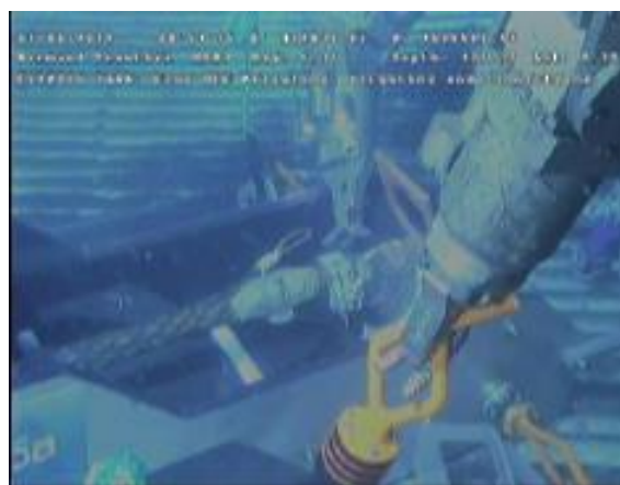
Figur 6-101 Antirotasjonsklemme installert på HFL UL-18-7032
