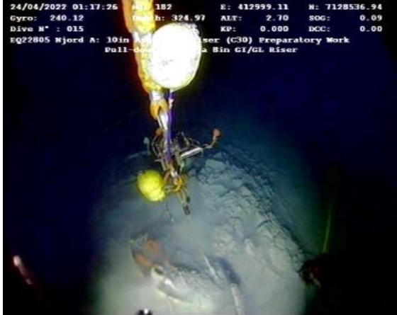
Figur 6-49 Landing av klumpvekt – Forsøk 3
