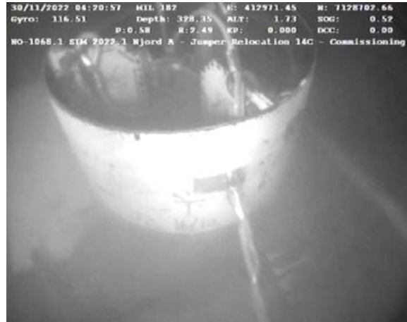
Figur 6-121 Installasjon av klumpvekt
