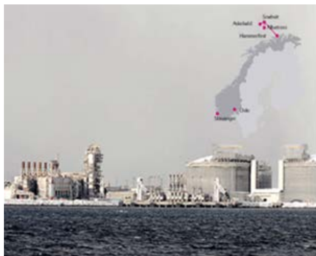
Figur 1.1. Beliggenhet av Hammerfest LNG og Snøhvitfelt
