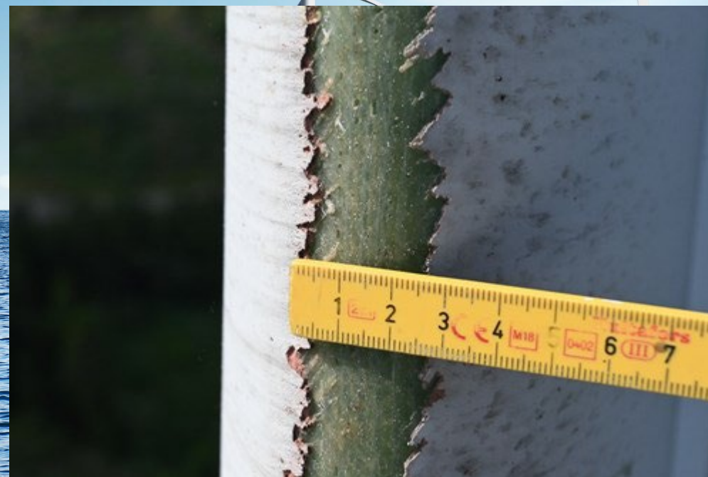
Errosjon av coating på turbinblad. Foto: NVE
