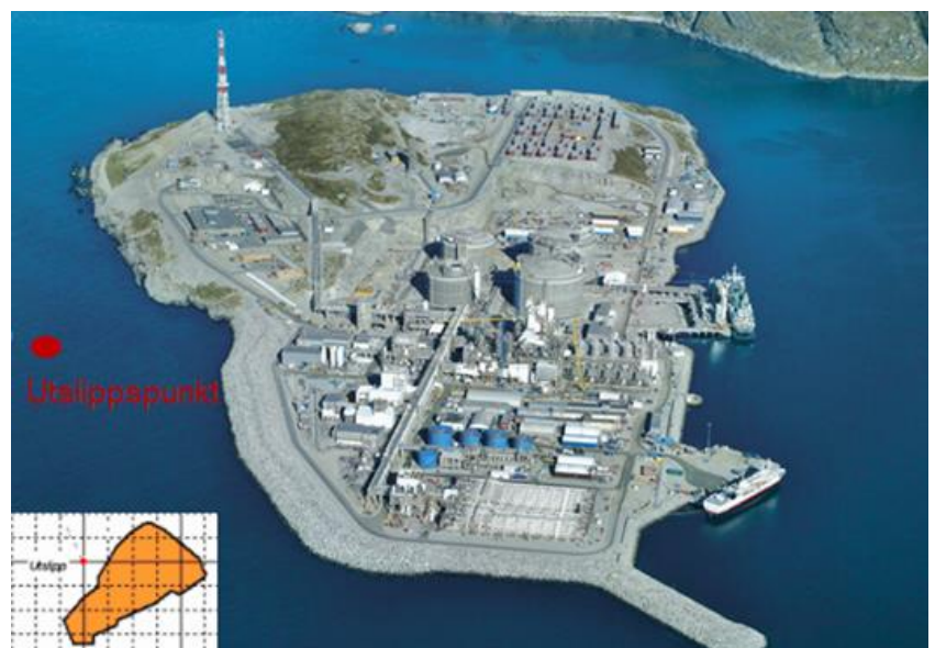
Figur 3.1. Hammerfest LNG og utslippspunkt for produsert vann. Utslippspunkt fra vannrenseanlegg 130 m fra land på 30 m dyp
